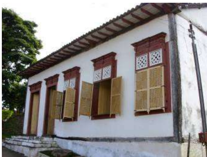
Figura 2: Casa da Princesa, Pilar de Goiás-GO. 2009.
