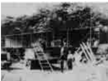
TRABALHADORES VINDOS DE ARAXÁ (MG) ajudaram a construir a residência provisória do presidente da República na nova capital. O Palácio de Tábuas - depois denominado Catetinho - foi erguido em apenas dez dias.
