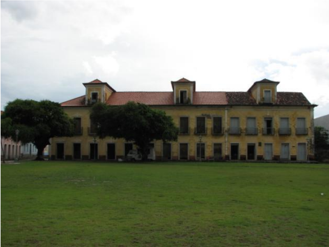
Figura 1: Fachada Museu e anexo
