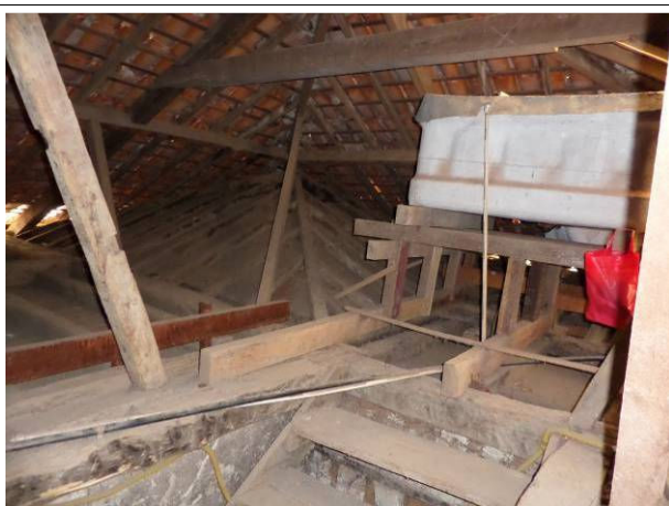
Foto 29: Vista da estrutura e caixa d'água
