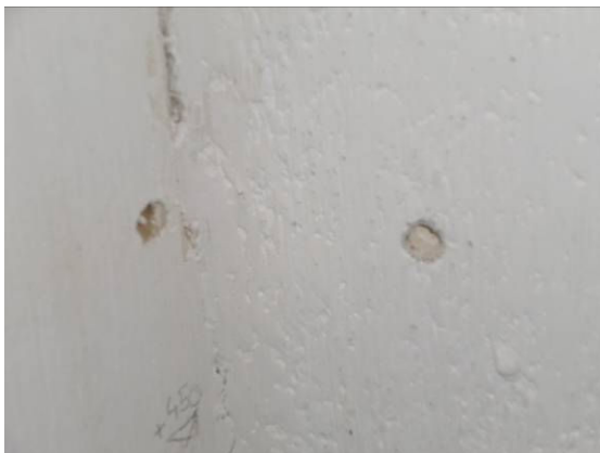
Figura 10: P10 mostra a mesma parede pelo lado oposto, no cômodo 10, verificando-se a existência de esteio embutido na parede, no ponto abaixo da viga principal do telhado.
