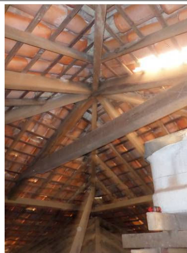
Foto 28: Detalhe tesoura de sustentação telhado.
