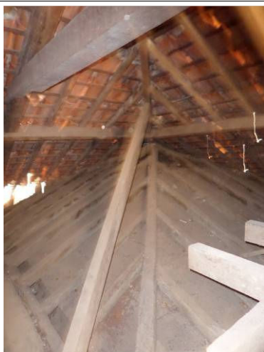
Foto 27: Vista da cobertura e estrutura de forro caixão do cômodo 06.
