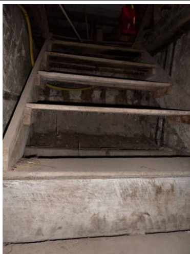
Foto 25: Escada de acesso à cobertura.
