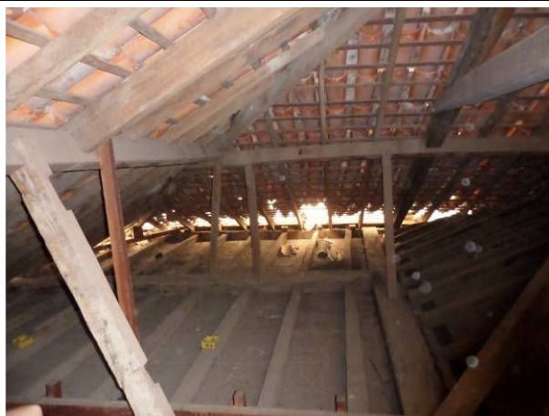
Foto 26: Vista da cobertura e estrutura de forro do cômodo 10.
