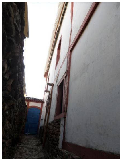
Foto 33: Fachada lateral direita
