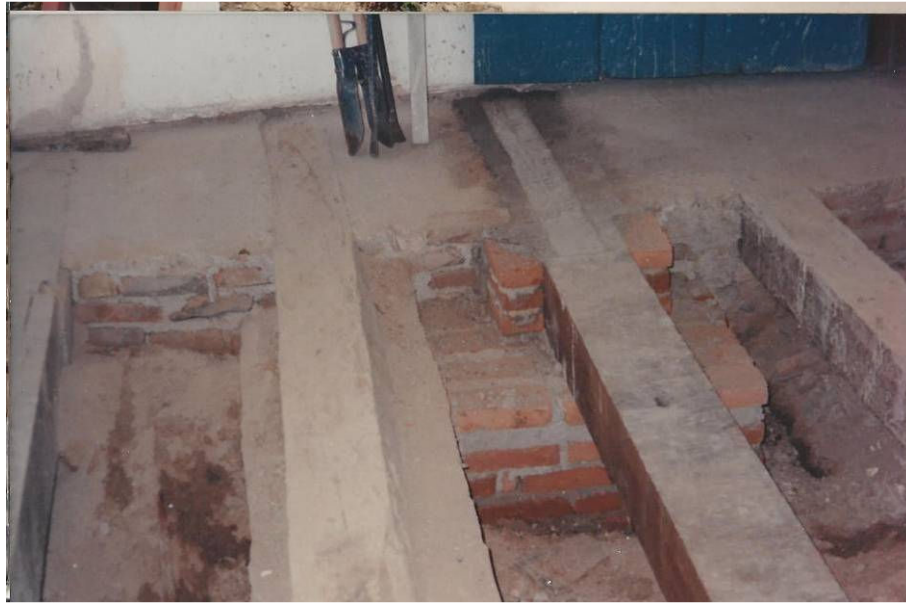
Figura 18: Foto tirada durante a intervenção, no ano de 1982. Vista substituição de baldrames, barrotes e piso dos cômodos 01 e 02. Os baldrames passaram a ser de tijolo cerâmico maciço e o sentido do barroteamento foi invertido. Pela parede externa, na fachada noroeste, ainda atualmente se observam resquícios do antigo barroteamento. (Fonte: Arquivo Museu Regional de Caeté, 1982).
