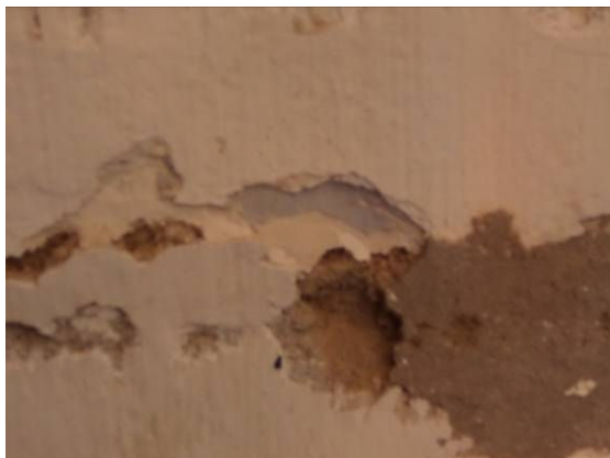
Figura 14: Detalhe Ponto 12, se prospectou e se verificou alvenaria de adobe, revestida com massa de preparação e pintura a cal na cor branca. Esta parede foi executada no ano de 82, pois a original em pau-a-pique estava comprometida por ataque de térmitas.
