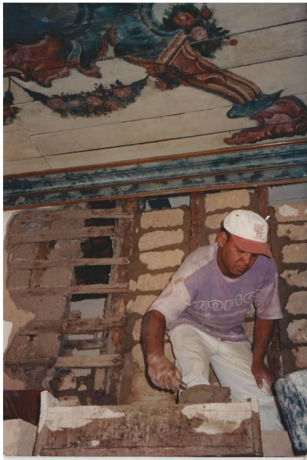
Figura 19: Foto tirada durante a intervenção, no ano de 1982. Vista substituição das paredes de pau-a-pique da capela, no 2º pavimento, por técnica mista, consistindo em preenchimento da trama de madeira com tijolos de adobe, assentados com argamassa à base de cimento. Também se encontrou fotos do madeiramento do pau-a-pique totalmente atacado por térmitas. (Fonte: Arquivo Museu Regional de Caeté, 1982).
