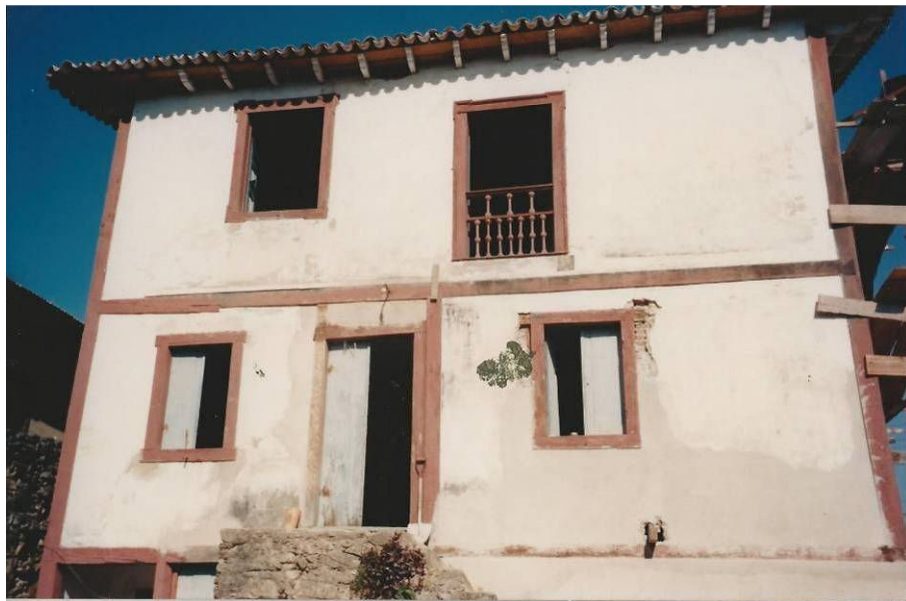
Figura 17: Foto tirada durante a intervenção, no ano de 1982. Vista da fachada posterior. Nota-se o uso indiscriminado de argamassa de cimento na restauração das alvenarias, incluso no engaste das peças em madeira. . (Fonte: Arquivo Museu Regional de Caeté, 1982).
